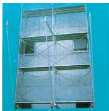
斜材を持ち上げピンをセットし、カプラーを仮止め
