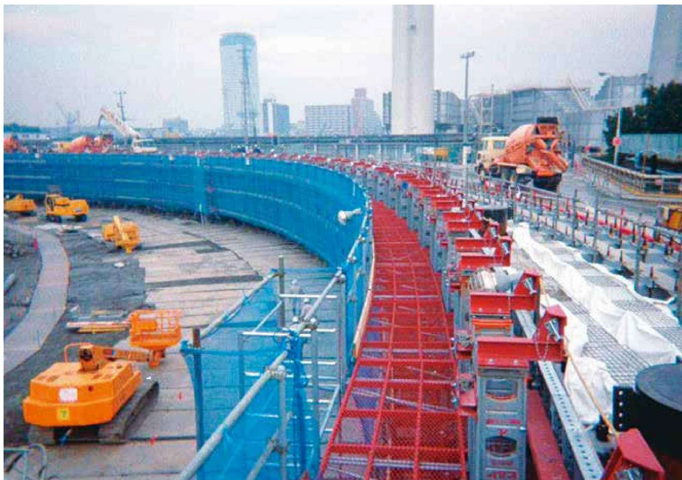
円形コンクリートタンク
