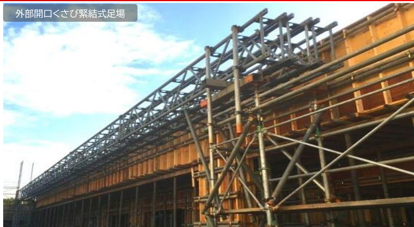
外部開口足場
